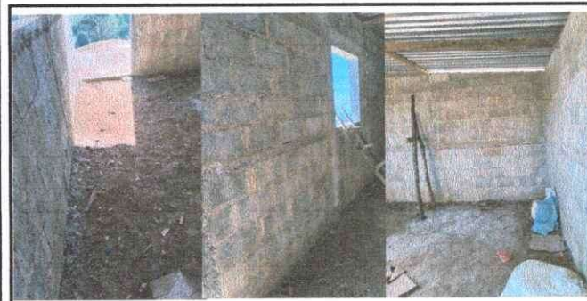
Foto 3: Repello de pared y entortado de piso
