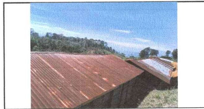
Foto 6: Cambio de láminas para el entechado
