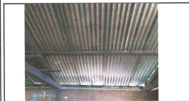
Foto 5: Cambio de láminas para el entechado
